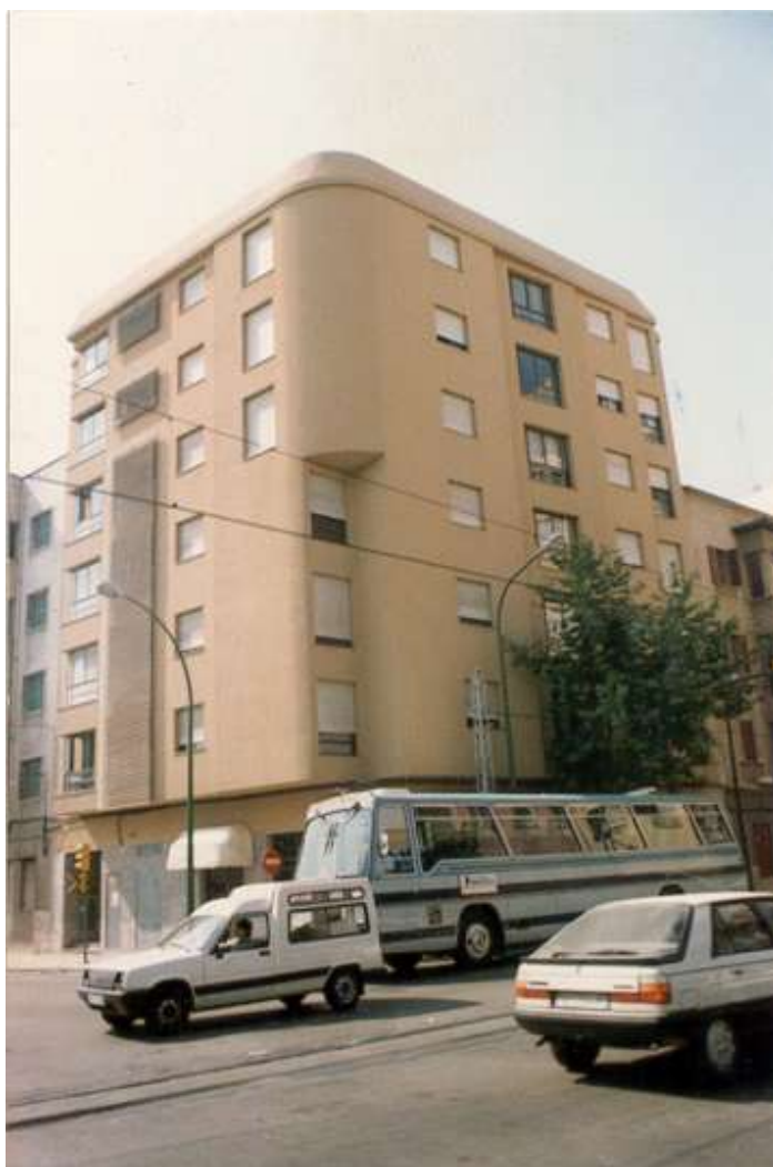
Ilustración 4 - Fotografía de fachada.
